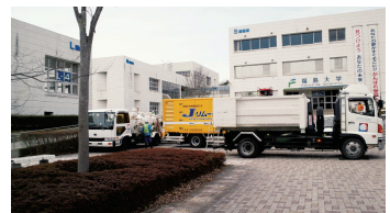
福島大学での除染作業 (2012年3月22日撮影)
