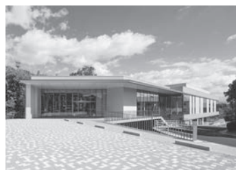
図2 令和元年に完成した新棟
